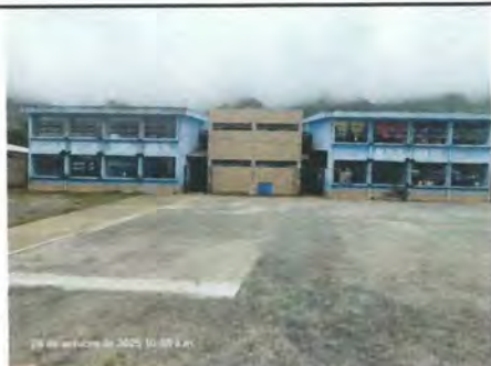
Foto 11: PINTURA PARTE FRONTAL DE LA ESCUELA
