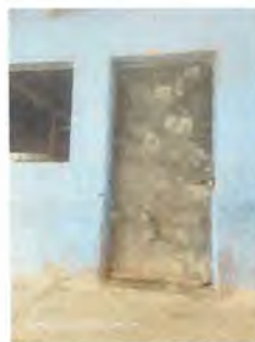
Foto 8: PUERTA DE METAL PARA ACCESO LATERAL EN LA COCINA
