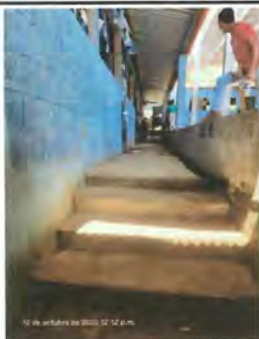
Foto 3: SUSTITUCIÓN DE PISO DE CONCRETO POR PISO ANTIDESLIZANTE EN EL PATIO 1
