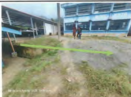
Foto 5: INSTALACION DE MURO DE MAMPOSTERIA
