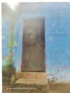
Foto 7: PUERTA DE METAL PARA ACCESO PRINCIPAL EN LA COCINA
