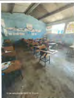
Foto 1: SUSTITUCIÓN DE PISO DE CONCRETO POR PISO CERÁMICO EN AULA 1,2,3
